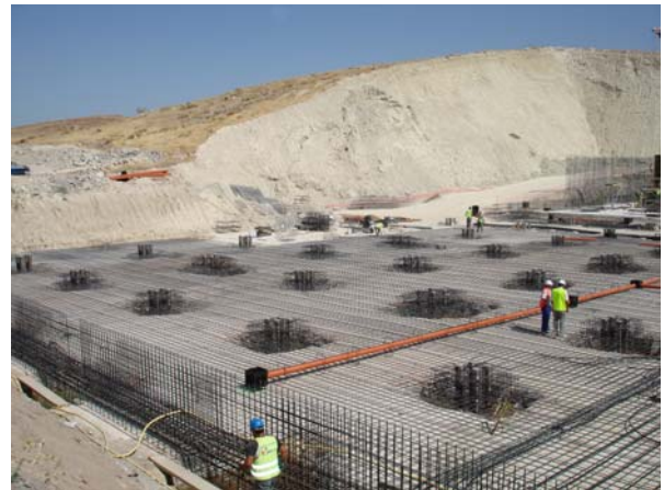
Proceso de armado de losa de cimentación y elementos de conexión pilotes, losa y pilares
