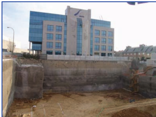
Ejemplo de estabilización con sistema INGEONAIL de 12m de profundidad mediante combinación de anclajes activo y pasivos conteniendo estructura medianera
