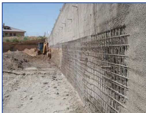
Detalle proceso constructivo sistema INGEONAIL
