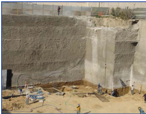
Ejecución de cimentación y muros con taludes de 14m contenidos con el sistema INGEONAIL
