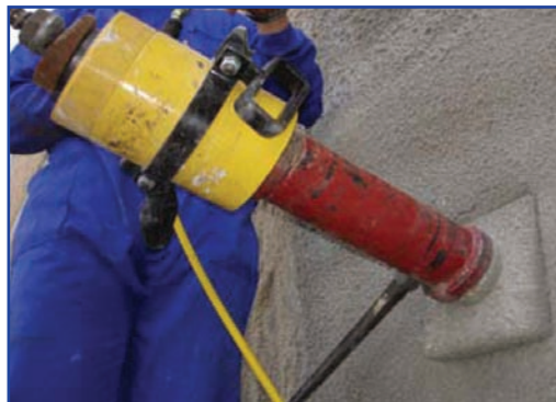
Detalle de tesado de anclajes
