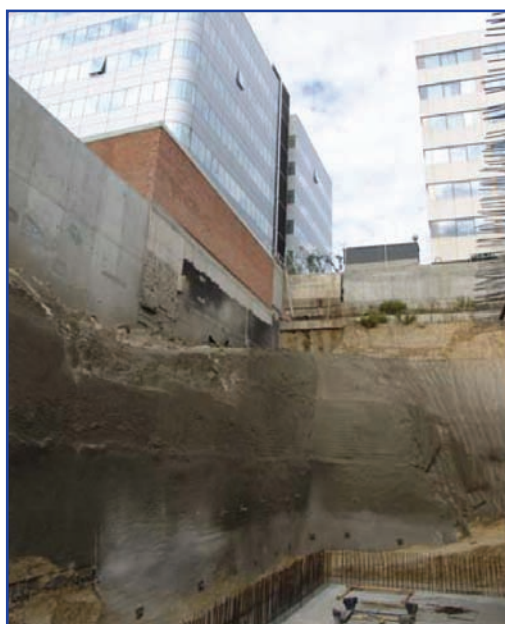
Contención provisional con sistema INGEONAIL
