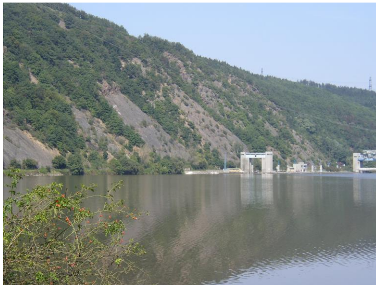
Foto de la sección más peligrosa - parte Vrane nad Vltavou (foto S.Chamra)
