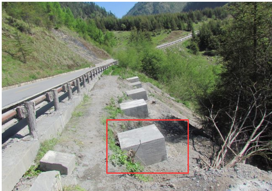
FIGURE 1 – Pieux stabilisateurs (tous sous le terrain)
