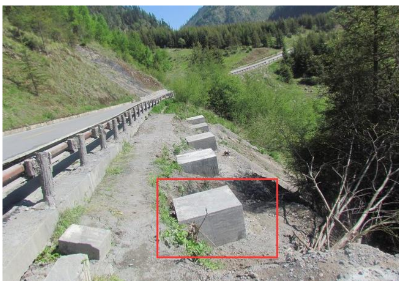
Megtámasztó cölöp (teljesen a terepszint alatt)
