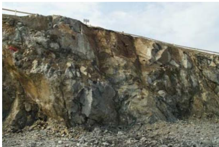
Obr. 1 Západní svah stavební jámy – foto L. Mařík
