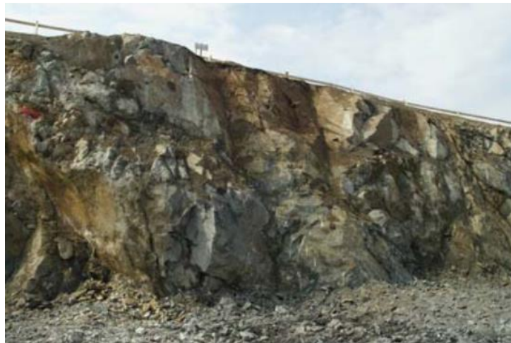
Abb. 1 Westhang der Baugrube - Foto von L. Mařík
