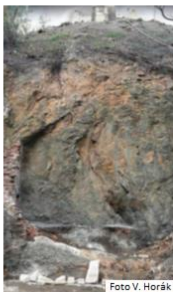
Pohled na skalní svah - místo řešeného řezu
